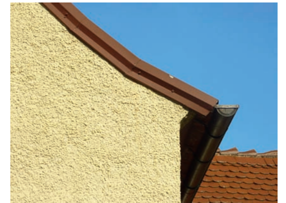
Traufdetail alt: mit Aufschiebling
