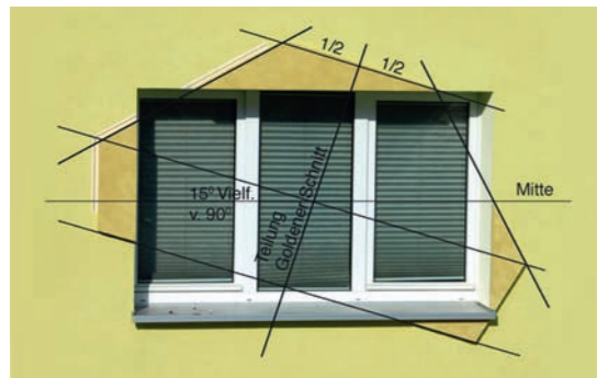
Fenster erstes Obergeschoss
